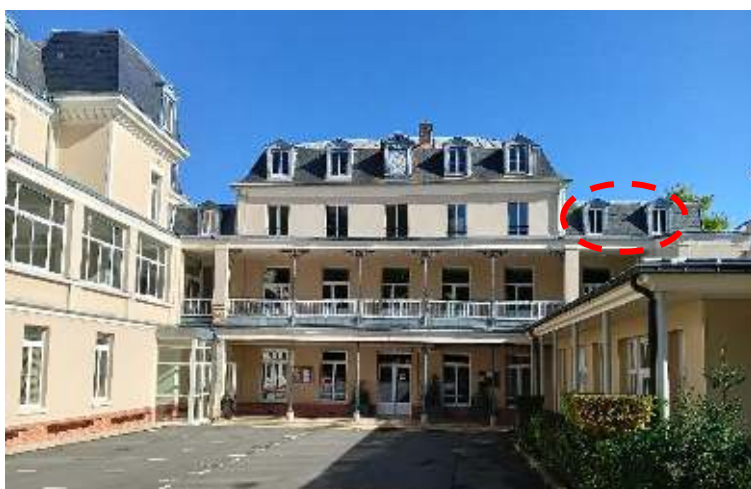
Ci-dessus : Bâtiment central « Administration » et bâtiment « Denyse Marie » en octobre 2022.
